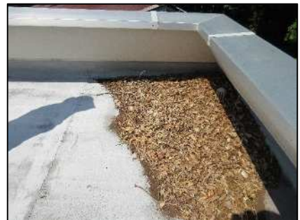
屋上排水口の詰まり
