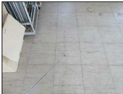
床材の亀裂
