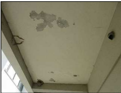
軒天の塗装の剥がれ
