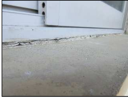
窓枠目地シーリングの破断
