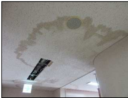
天井の漏水痕
