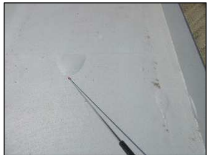
防水シートの膨れ
