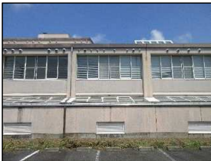
外壁の塗装の劣化・褪色
