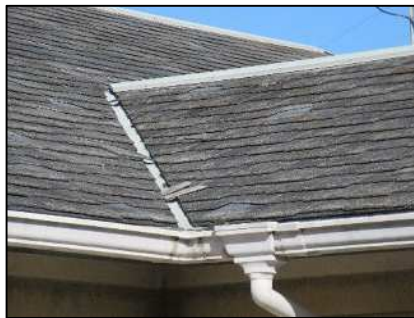
屋根材の剥離・飛散
