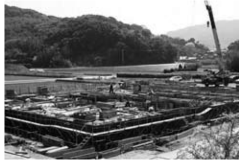
建設中の内原東地区汚水処理施設
