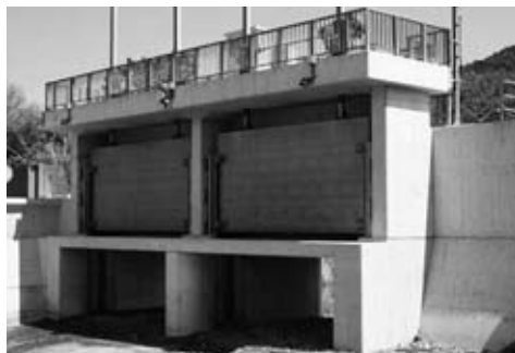
役場から遠隔操作できる産湯川水門
