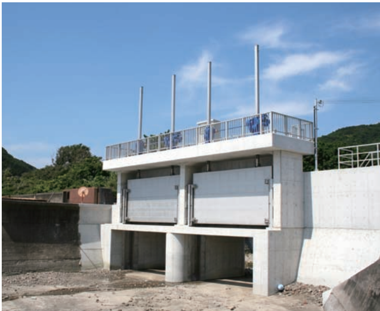
産湯川水門 (H18年6月完成)
