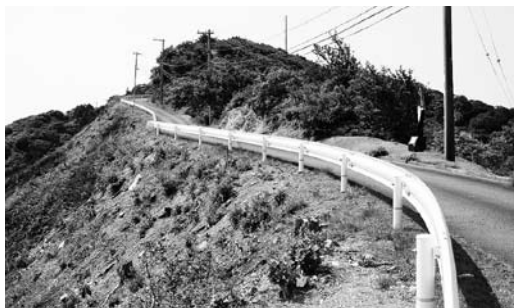
新設のガードレール
