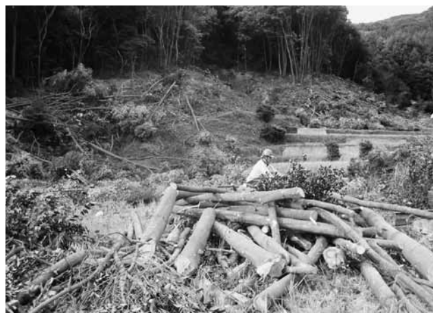
山裾の樹木を伐採して緩衝帯をつくる
