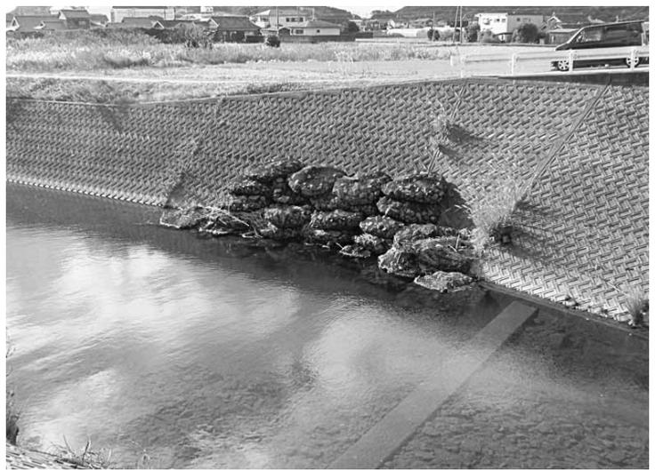
一部陥没したブロック積の現場
