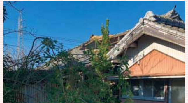
急がれる空き家対策
