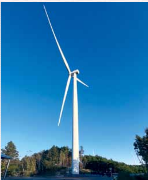
陸上では最大級の風力発電施設
