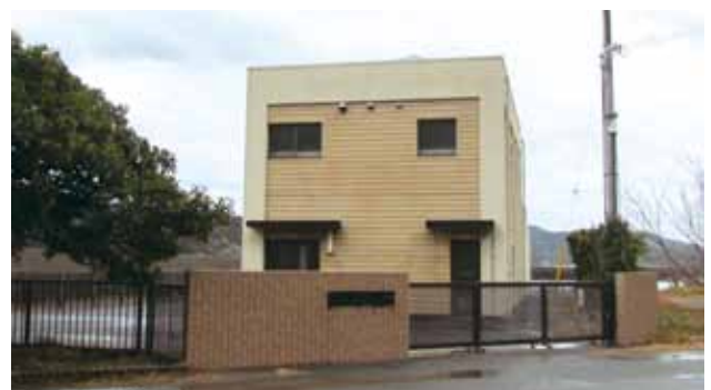
現在の小浦地区汚水処理施設
