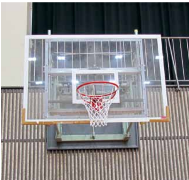
修繕が必要なバスケットゴール
