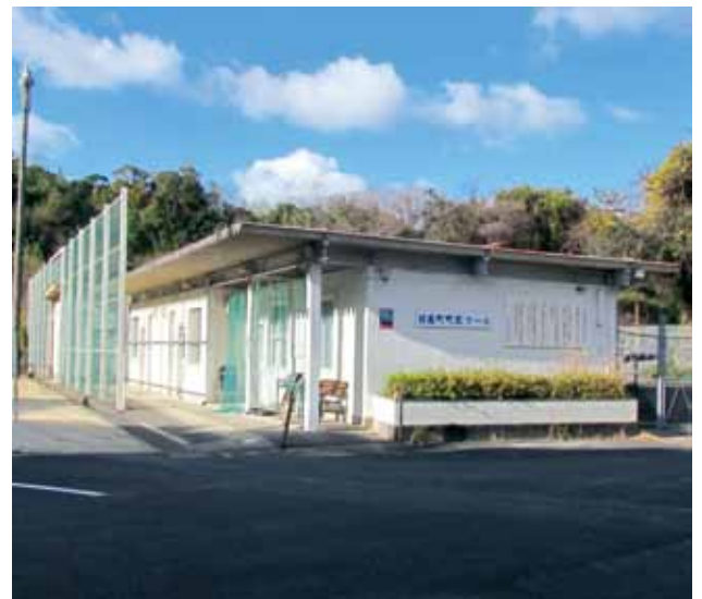
町民プールの濾過装置を修繕
