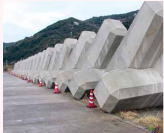
阿尾漁港で製作している消波ブロック
