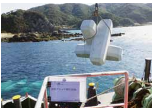
工事中の田杭漁港
