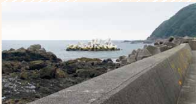
工事中の田杭漁港防波堤
