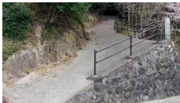
山側に手すりを設置（柏地区）
