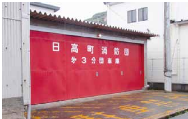
移転する比井消防車庫
