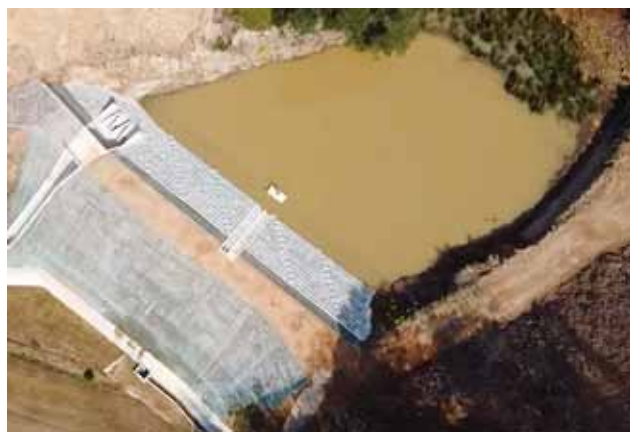
工事が完了したテナル池
