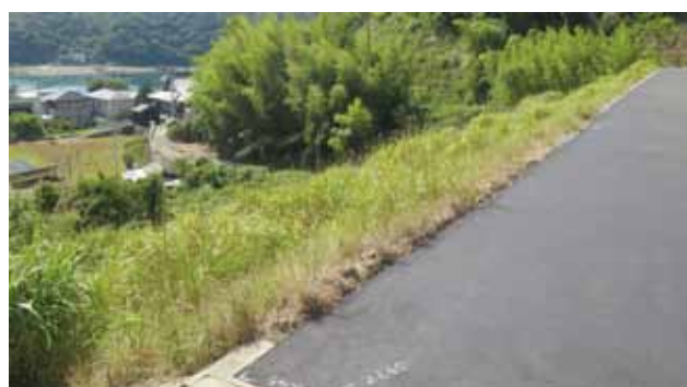
転落防止柵を設置（比井地区）
