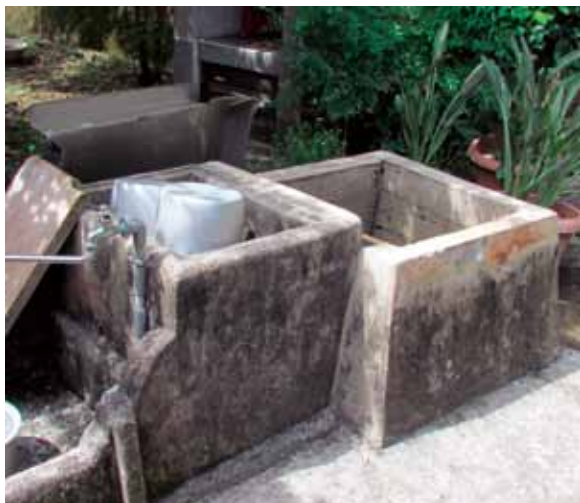
災害時に井戸水が活用できる仕組みを
