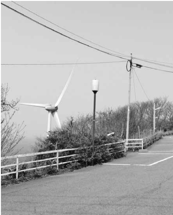
田杭に1基ある1990kwの風車
