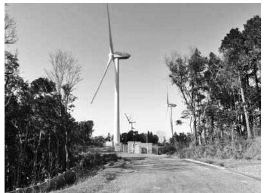
風力発電施設 (由良町内)
