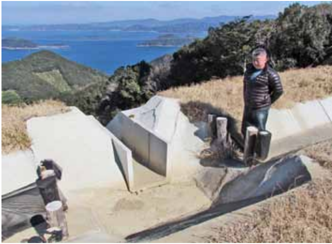
時間雨量150mmで設計された排水溝（由良風力）
