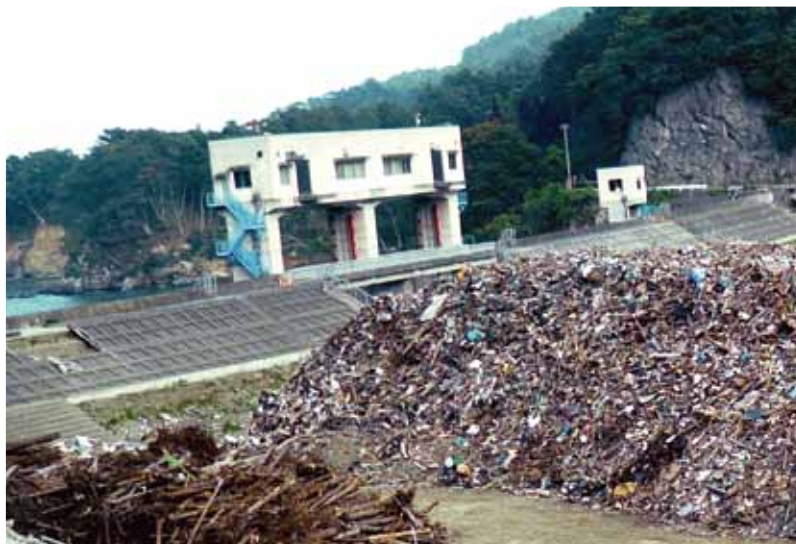
津波は堤防と水門を乗り越えた（釜石市）
