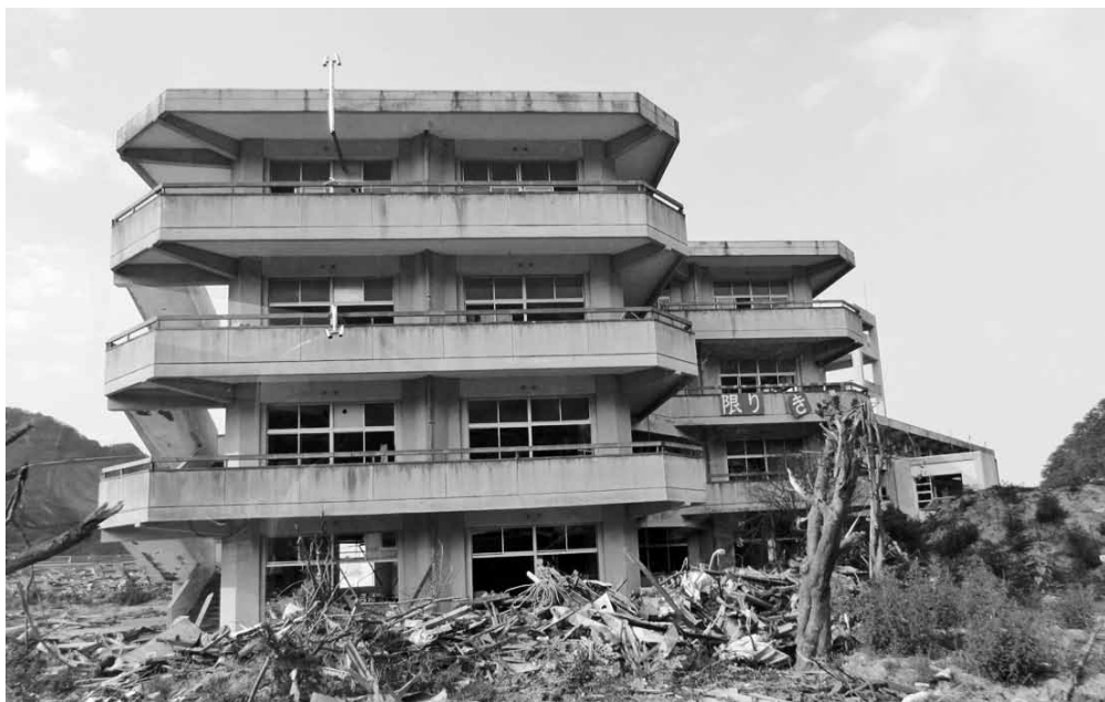
被災した釜石市立鶺住居小学校
