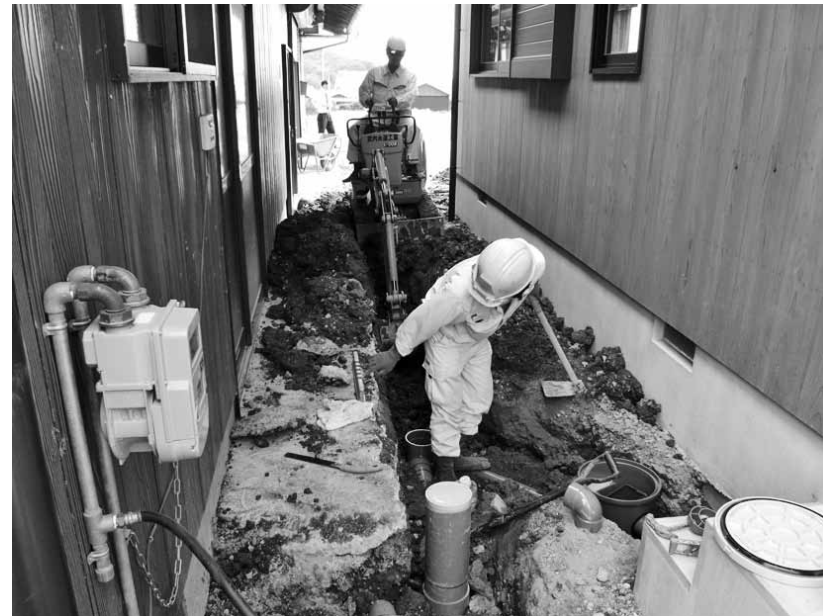
下水道接続工事現場
