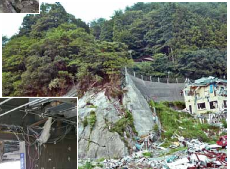
急傾斜の上まで津波が押しよせた （釜石市両石町）
