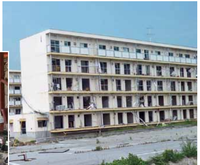
4階まで津波が到達した（陸前高田市雇用促進住宅）
