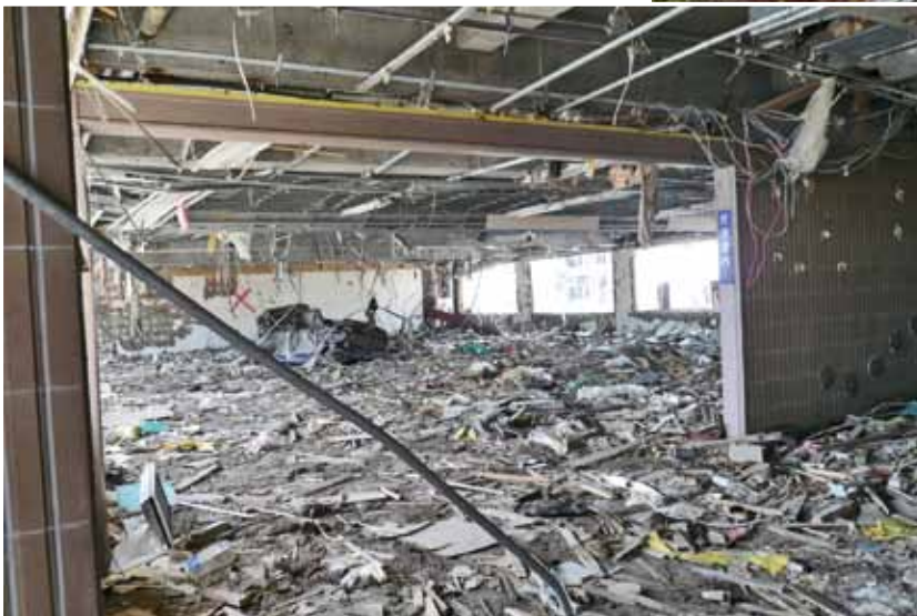
壊滅的被害の陸前高田市役所一階フロア
