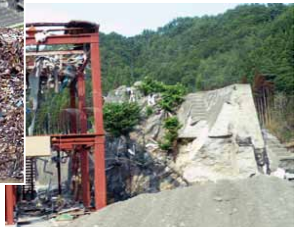
防潮堤が津波で倒されている（釜石市）
