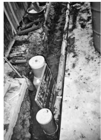
宅内配管工事現場
