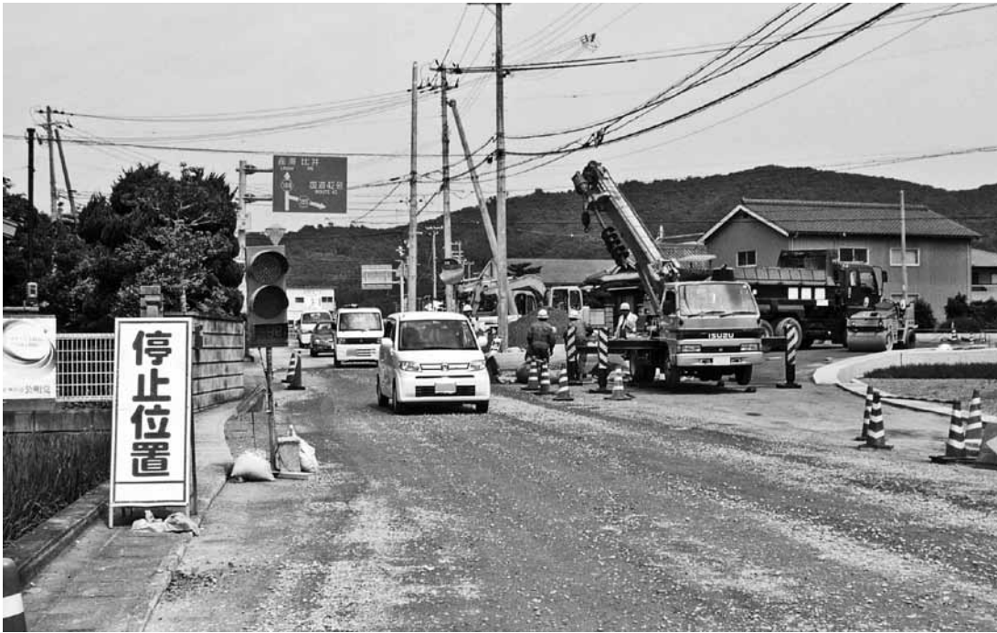
工事中の谷口交差点
