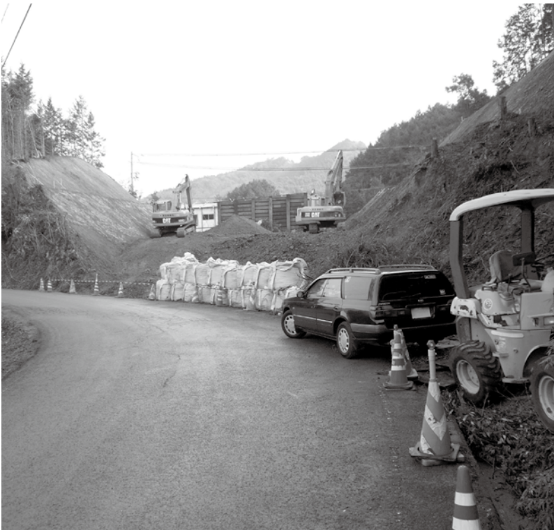
特定財源に関係ある県道改良工事（原谷地内）
