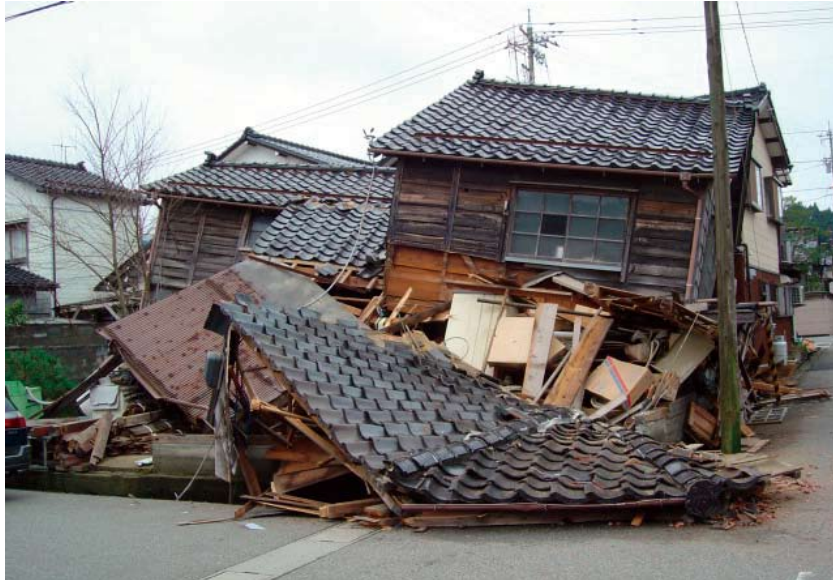
家屋倒壊現場（平成19年3月25日発生直後）
