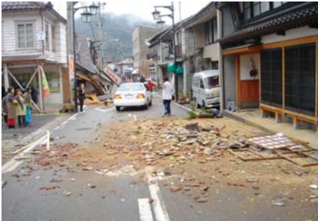
商店街の状況（平成19年3月25日発生直後）
