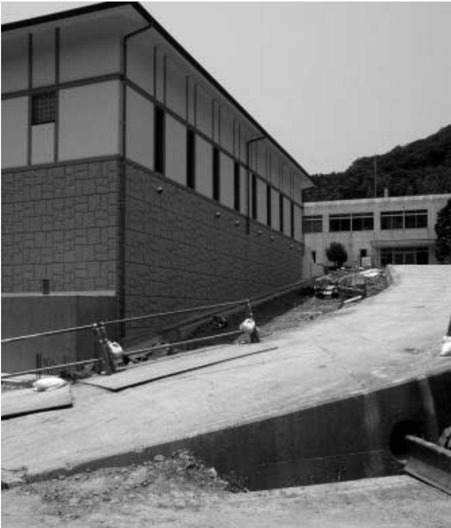
来年2月完成の浄水場工事
