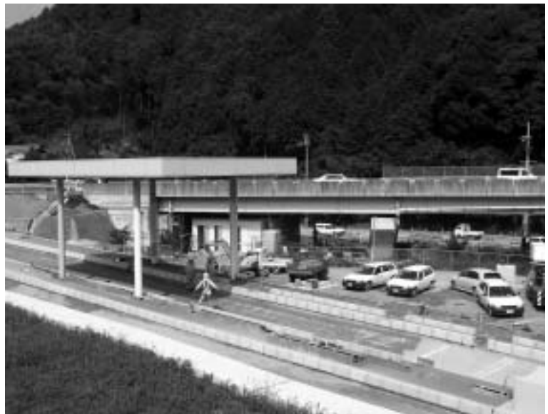
完成間近の広川南インターチェンジ
