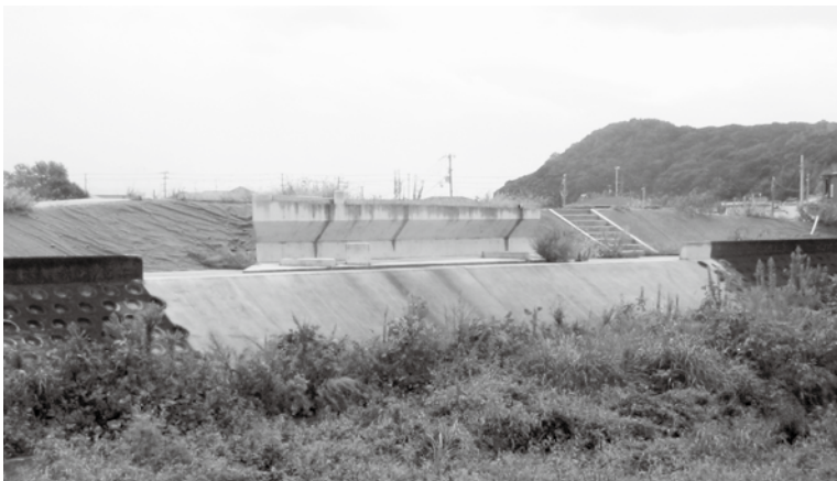
上部工の施工を待つ橋台（天満井橋）
