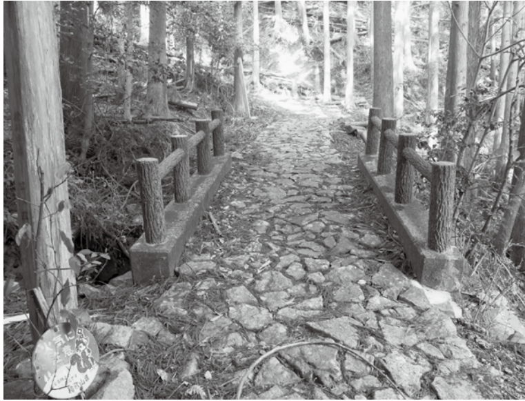
国の史跡として指定される予定の鹿ヶ瀬峠 石畳道
