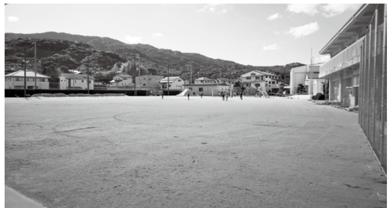
排水改良工事を行う志賀小学校グラウンド
