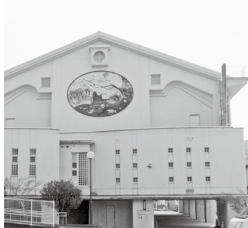
「比井崎体育館」として再活用が始まる
