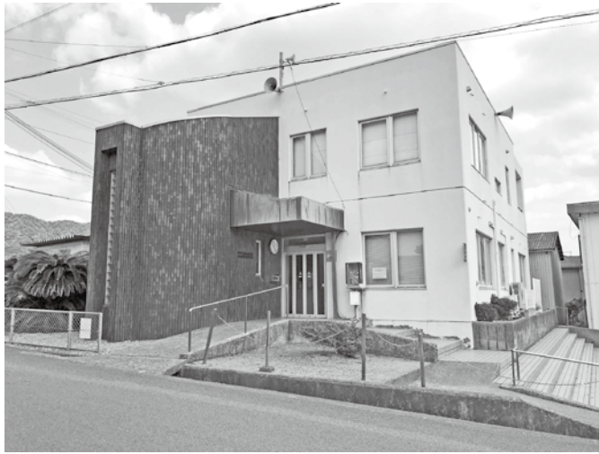
修繕される昭和57年建築の文化会館
