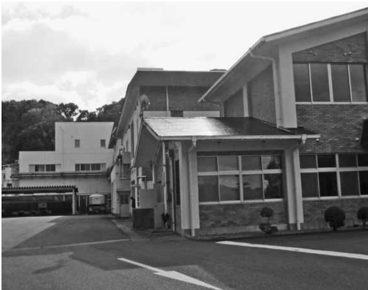
新設が予定されているクリーンセンター
