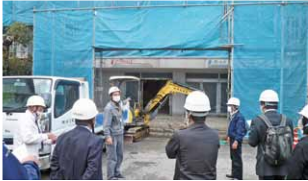
改築・増築工事の現地を視察
