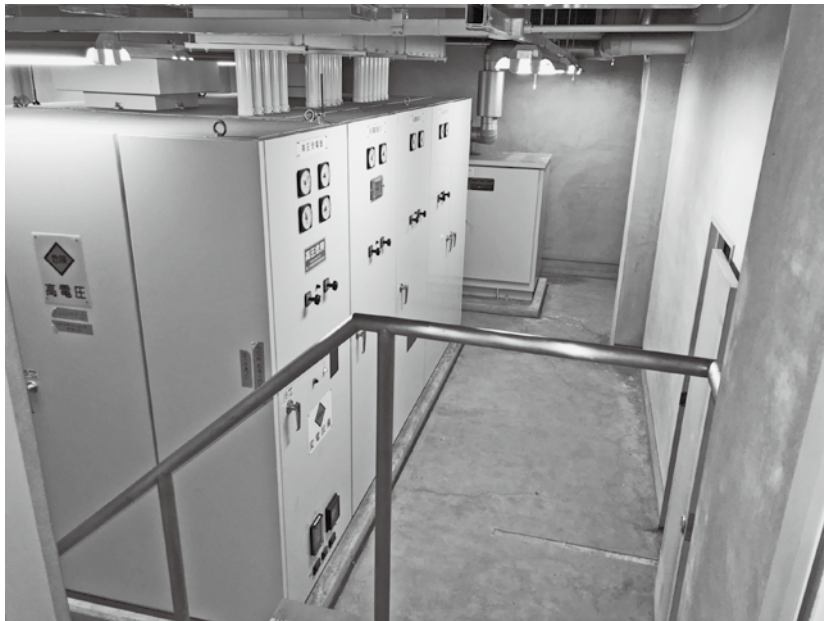
新設移転されるキュービクルと自家発電機
