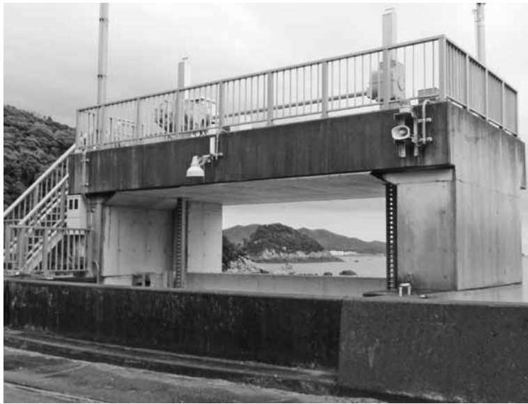
停電時も水門の自動開閉を可能にする
