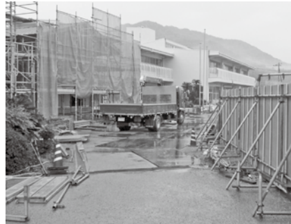
増改築工事が進む志賀小学校
