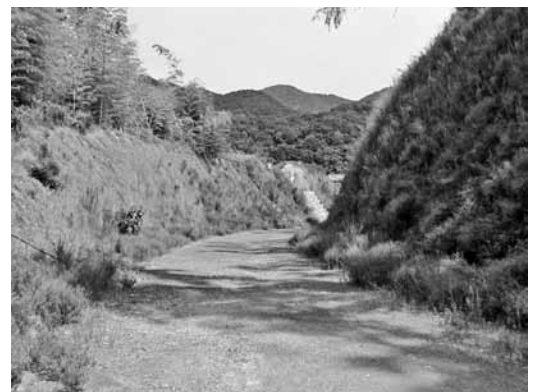
比井漁港集落道改良工事
