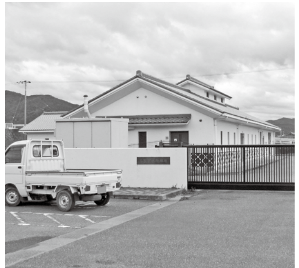
高家下水処理場
