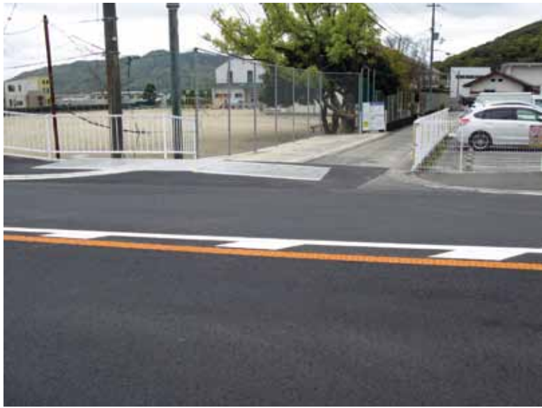
改良工事が完成した進入路交差点
