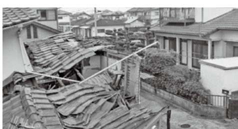
熊本地震での被害家屋
