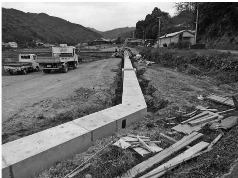
原谷地内での工事状況
