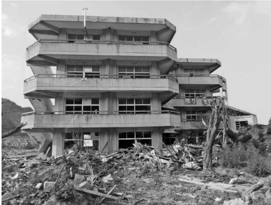
いつ起こるか分からないのが災害である
