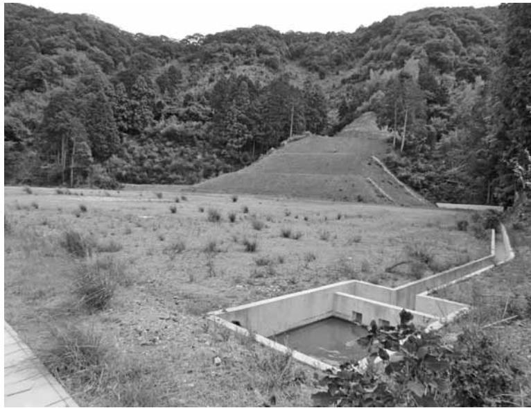
肥料工場の建設予定地（原谷）
