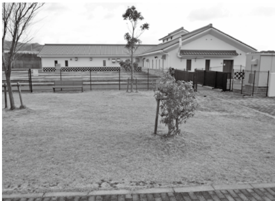
高家下水処理場
