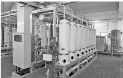
機械設備が老朽化してきた浄水場
