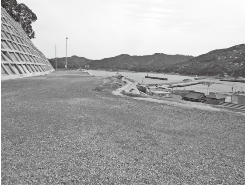
完成間近の阿尾避難広場
