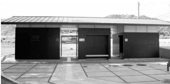
完成した、内原王子神社付近の公衆便所
