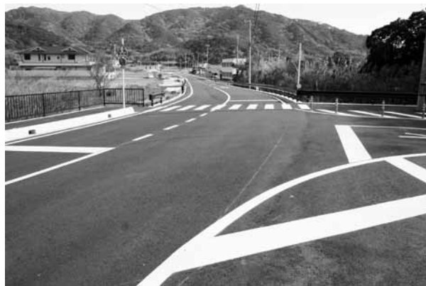
整備が進む道路(産湯地区)
